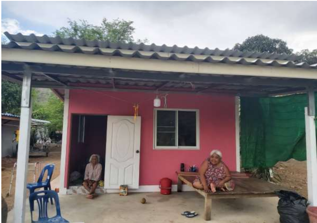
ประมวลภาพ หลัง การซ่อมแซมปรับปรุงสภาพที่อยู่อาศัยของคนพิการ
